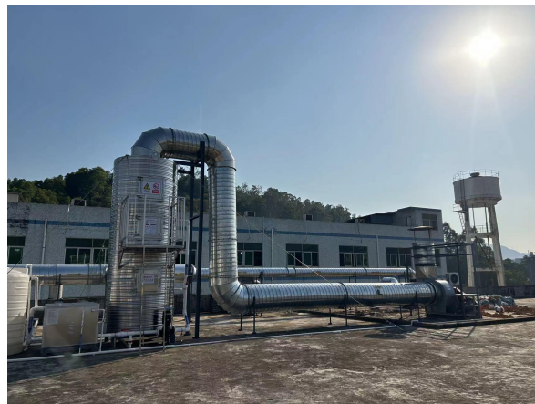
打磨切割废气：高效离心分离圆形除尘塔
